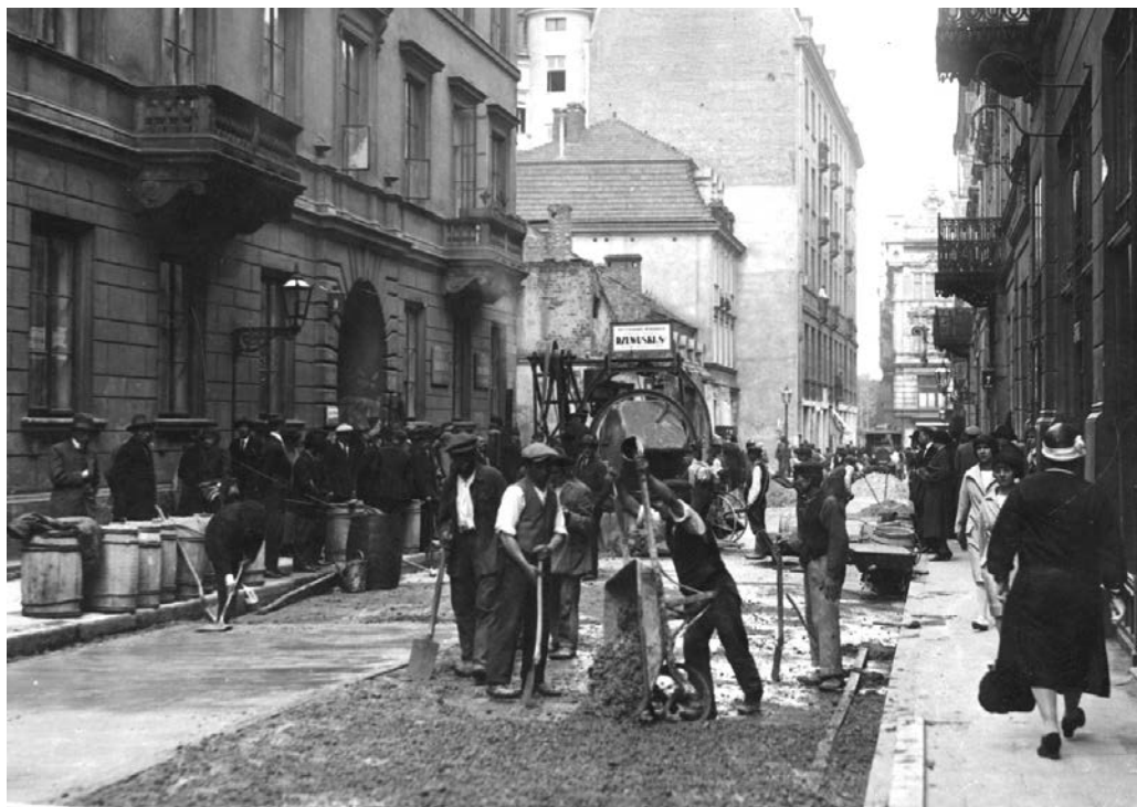
Robotnicy wylewający asfalt na ulicy Chmielnej, 1926 r. W głębi po lewej stronie kamienica narożna M. Malinowskiego
