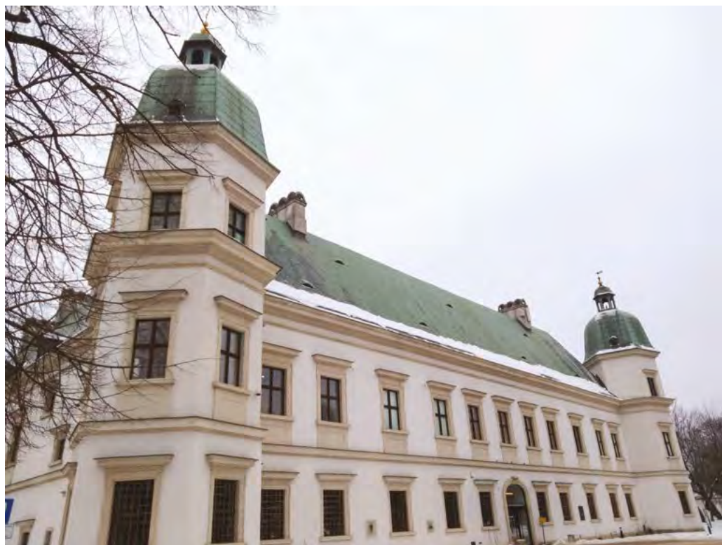
Widok fasady zachodniej
