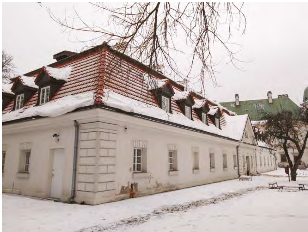
Widok od południowego wschodu
