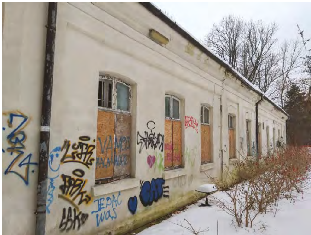
Widok elewacji północnej
