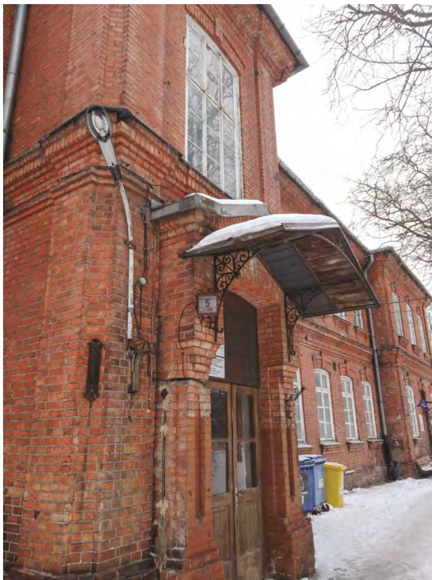
Detale wejścia od strony wschodniej
