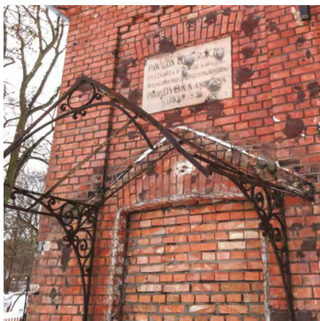
Widok wschodniej elewacji z tablicą i detalem
