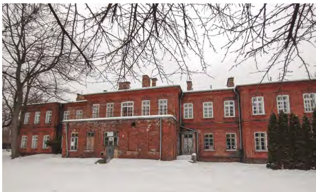
Widok elewacji zachodniej
