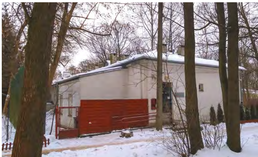
Widok zachodniego wejścia do budynku
